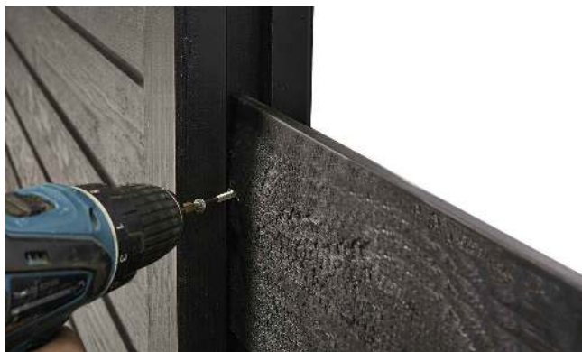
Fastgørelse af brædder, skrue i hver side.
